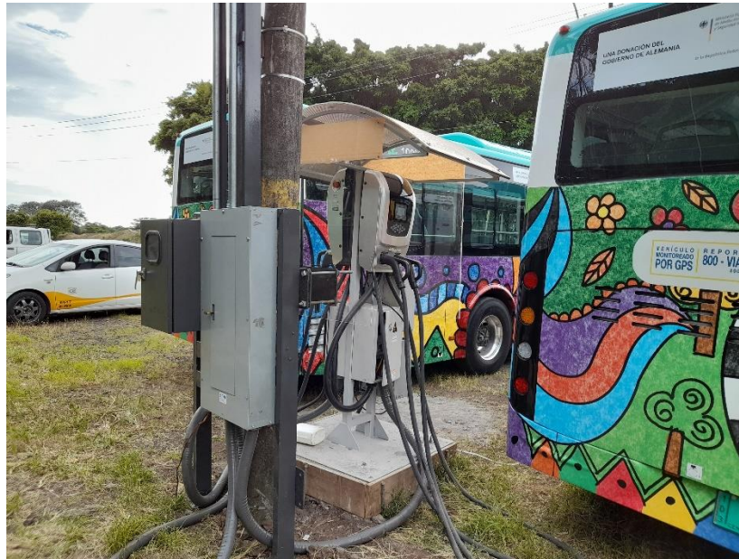
Figura 4. Instalación de cargadores en TUASA
