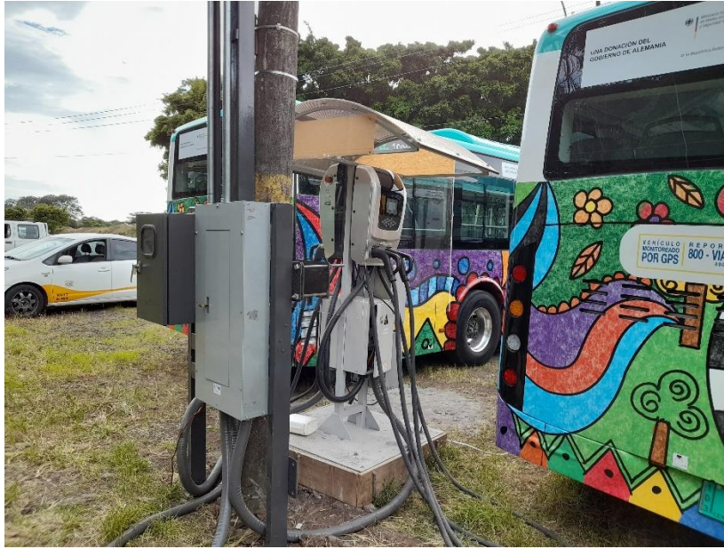
Figura 5. Instalación de cargadores en TUASA
